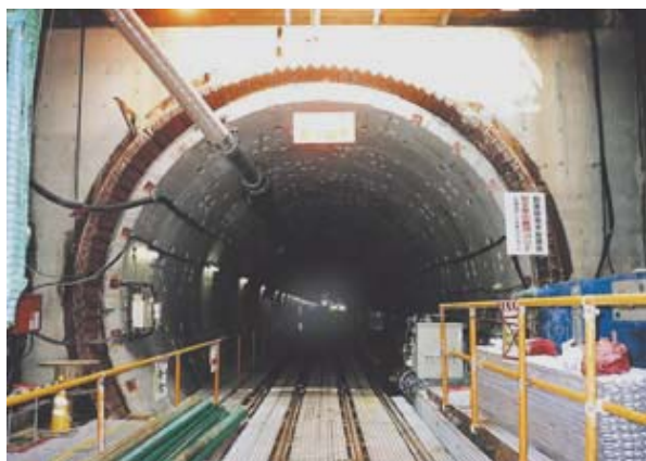
雨水幹線の進入口
