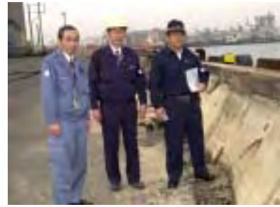
箱崎埠頭にて(1.2m 陥没)
